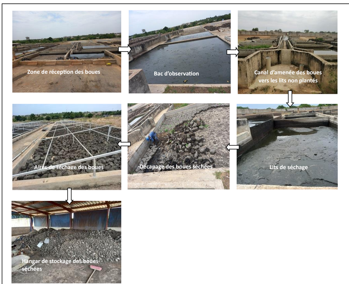
Figure 3: Photos des infrastructures de traitement illustrant le procédé de fonctionnement de la STBV de Korhogo
